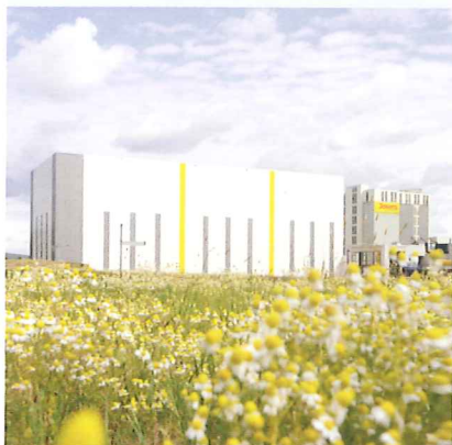
Mit 2.400 m 2 Grundfläche und 30 m Höhe eines der weltweit größten Hochregallager aus Holz.
